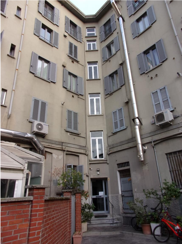
Foto 2: esterno ingresso scala nel cortile interno
