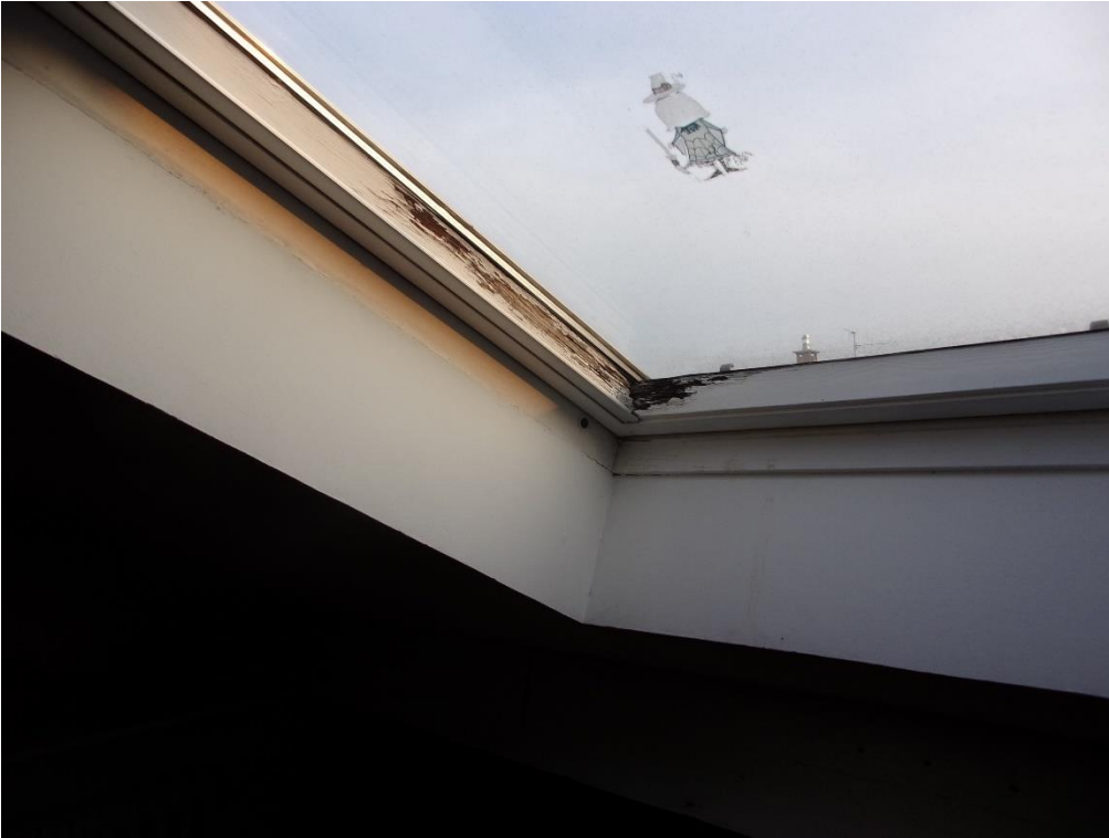
Foto 19: particolare lucernaio rovinato
